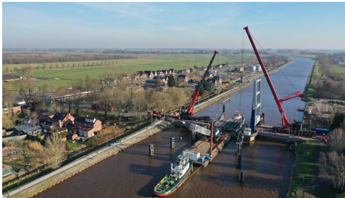
AFBEELDING 5.5 HERGEBRUIK BRUG. BRON: BRUGGENBANK 55
