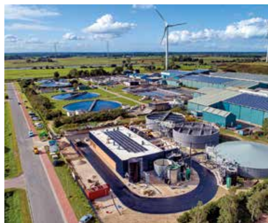
➤ De nieuwe grondstoffenfabriek in Zutphen.
