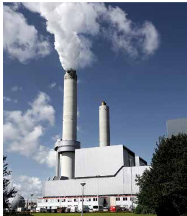
➔ Afval Energie Bedrijf (AEB) te Amsterdam.
