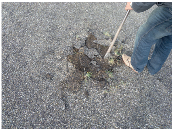
FIGUUR 6 CONTROLE VAN EEN OPBOLLING MET BEHULP VAN EEN STOOTIJZER
