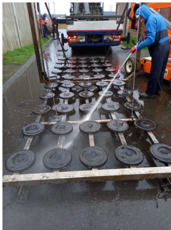
FIGUUR 3.4 A) REINIGING BELUCHTINGSELEMENTEN (LINKSBOVEN), B) AFKOPPELEN BUITENLUCHT (RECHTSBOVEN), C) AANSLUITING BEDIENINGSPANEEL PO BELUCHTING, D) OPBOUW PO BELUCHTINGSINSTALLATIE (RECHTSONDER)
